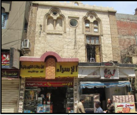
لوحة (٤): مسجد الأباصيري - الواجهة الجنوبية الشرقية المطلة على شارع طه الحكيم
